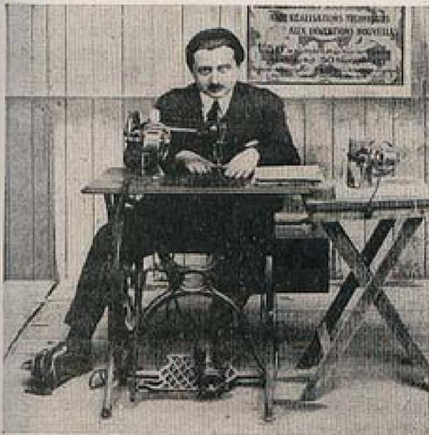
Fig. 134. — Moteur Lewis monté sur une machine à coudre.
